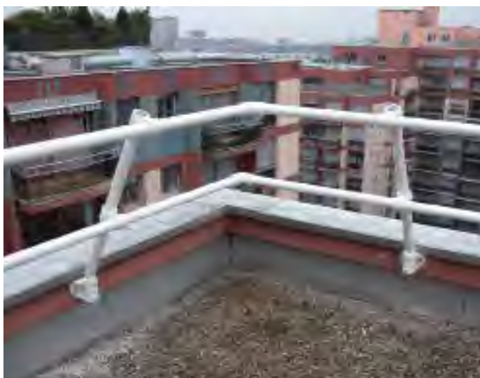
Kee Modules® 侧壁固定安装, 护杆同轴
